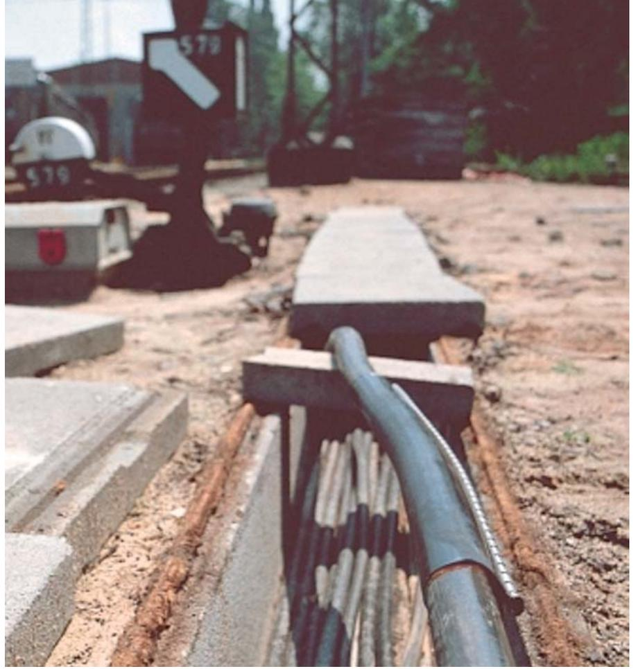
Almanya'da tren yollarında bulunan aşınmış kablolarda sızdırmazlık ve izolasyon iin kullanılan Raychem CRSM tamir kılıfı.
